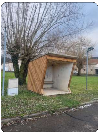
Abri bus au lotissement des Longes
