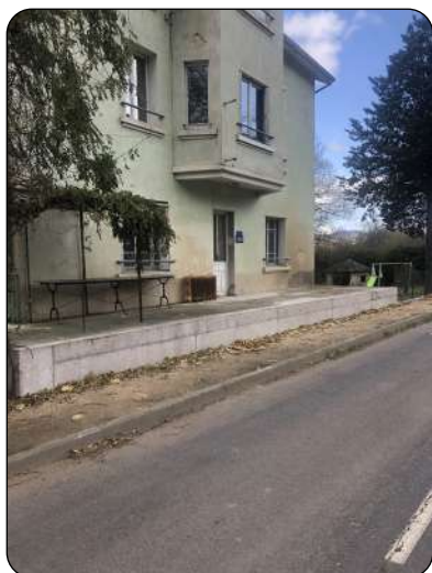
Alignement de voirie, confection d'un mur de soutènement et trottoirs avenue de la Condamine
