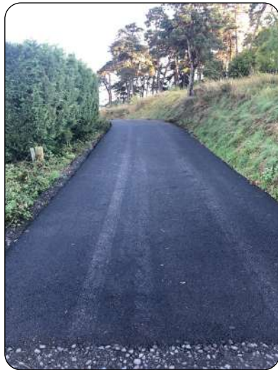
Réfection de la voirie de la roche haute
