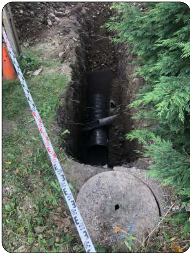
Travaux de reprise d'eau pluviale du verdier
