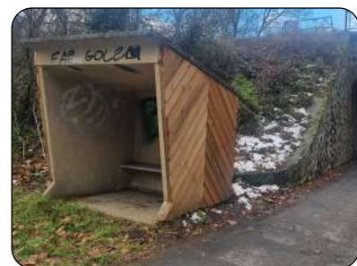
Abri bus au pont de Veyrac
