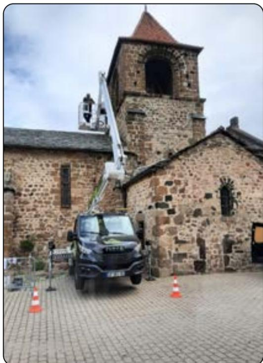
Des travaux ont été engagés sur le clocher de l'église, l'entreprise «Alti toiture» de Blavozy, intervient pour le démoussage de la toiture, la purge des façades du clocher et le nettoyage des toitures.
